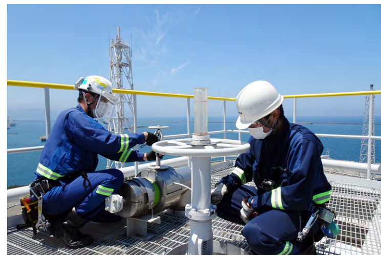
フェイスシールドとマスクを着用しての作業の様子 (直江津 LNG 基地)
