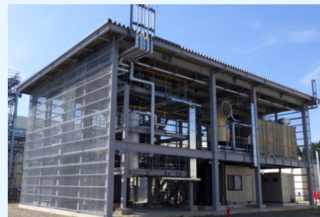
越路原プラント内の実証設備(NEDO 事業)
