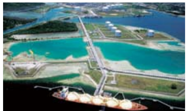
インドネシア ボンタンLNGプラント
