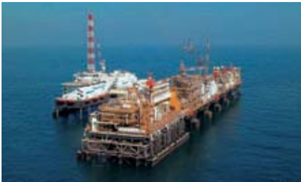
UAE ADMA鉦区 生産施設
