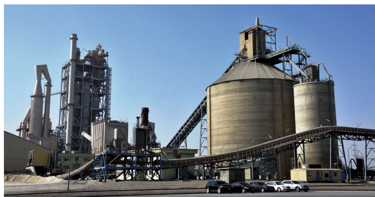
JELにおける掘削屑リサイクル
