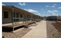
建設作業員宿泊施設操業開始
