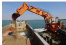
浚渫作業開始
