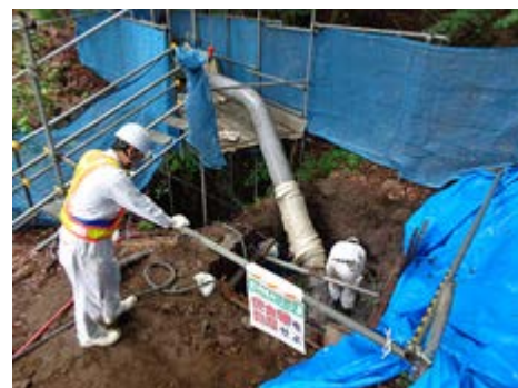
東京ラインの健全性調査工事現場
