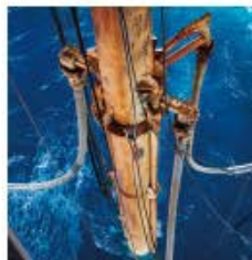
生産井掘削開始
