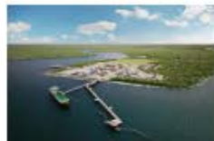
出荷桟橋建設完了
