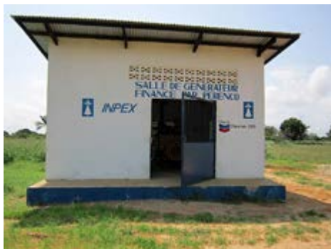
ムアンダ市内のガス設備施設
