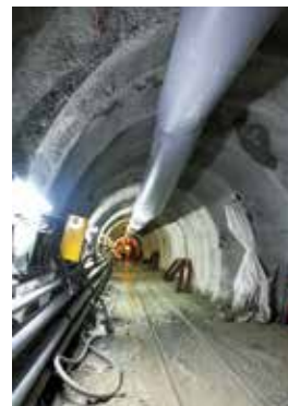
パイプライン敷設用トンネル内部の様子
