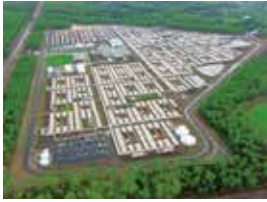
ダーウィン近郊の作業員宿舎
