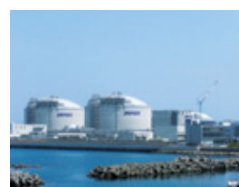
2013年12月に完成した直江津LNG基地
