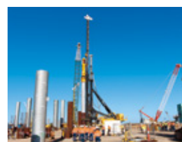
建設中のイクシスLNG陸上ガス液化プラント
